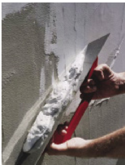
Natažení a srovnání stěrky
