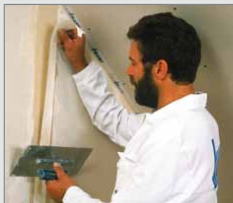
Vložení výztužné papírové pásky
