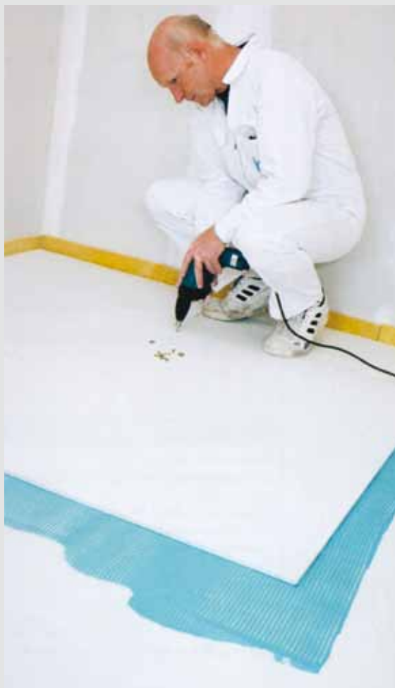
Šroubování 2. vrstvy podlah (F 135)
