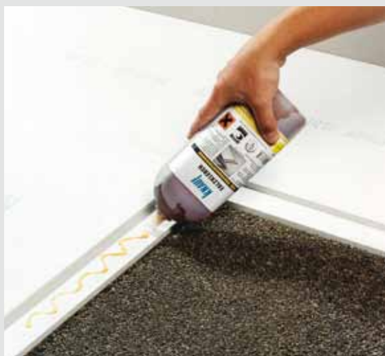
Nanesení lepidla na polodrážku (F 131)
